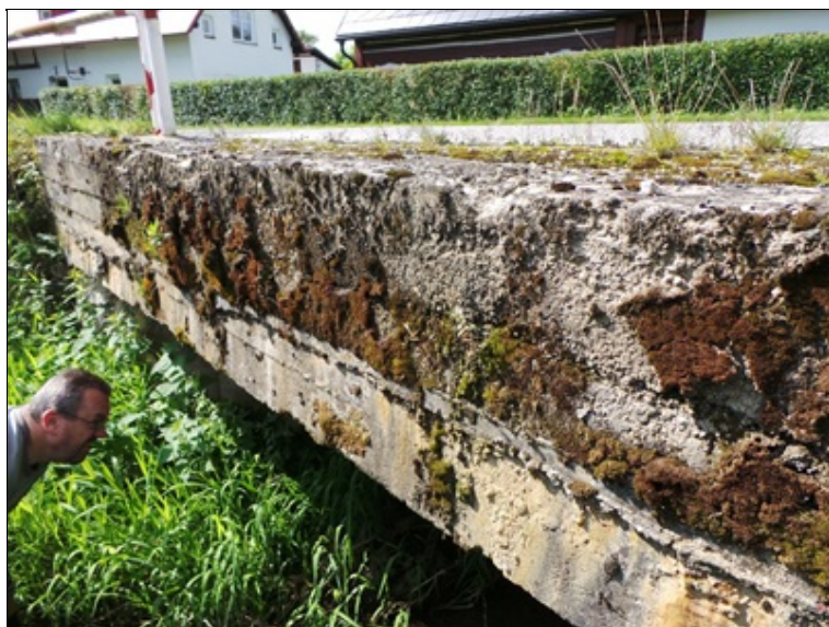
degradace betonu římsy
