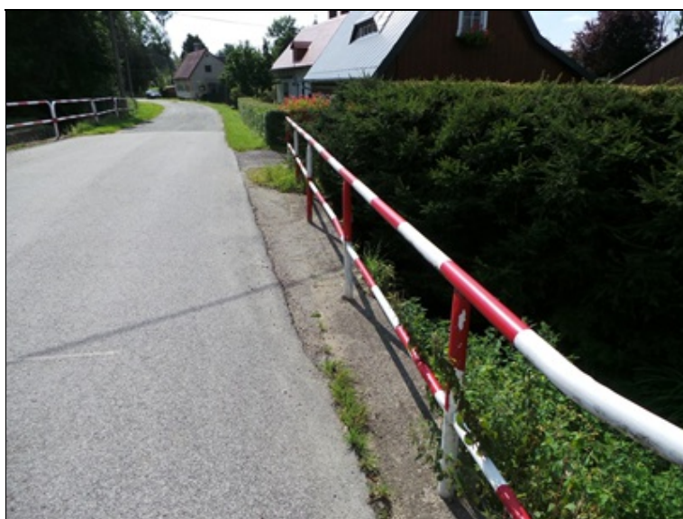
vegetace na krajích vozovky, na zábradlí lokálně odpadává nátěr
